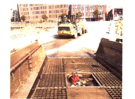
Sauber: Um lästigen Staub zu reduzieren, steht eine Reifenwaschanlage für Lkw vor der Baustellenrampe. Foto: Viktor Eskilgloju
