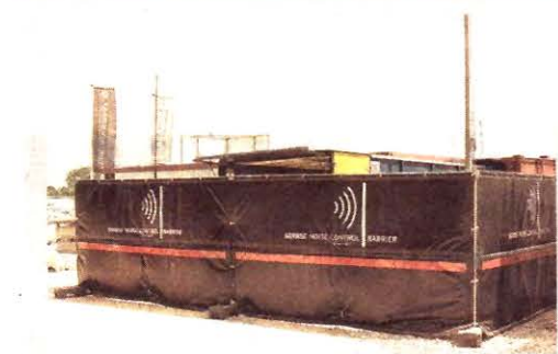
Schallschuttmatten: Um bis zu 20 db(A) sollen Matten aus glasfaserverstärktem Kunststoff den Lärm mindern können. Foto: Heras Mobilraum
